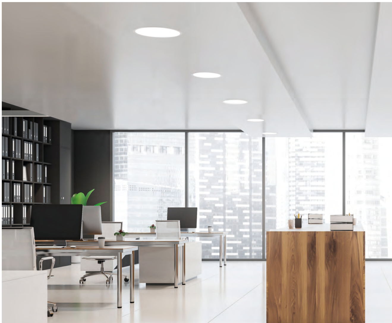
Ceiling lamps / Iluminación de techo
